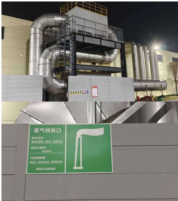
有机废气处理设施及标识标牌 DA003
