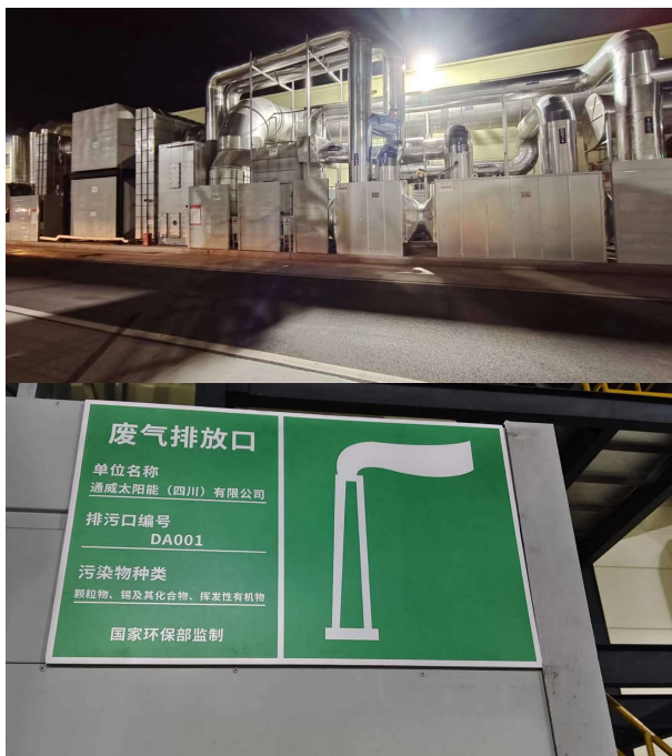
焊接废气处理设施及标识标牌 DA001
