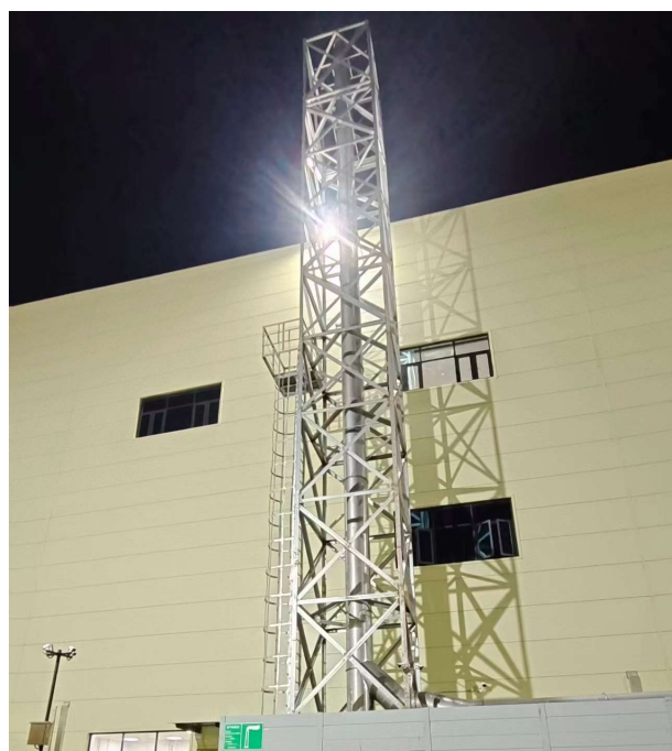
实验室废气排气筒 DA008
