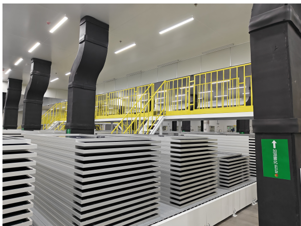
固化间废气收集
