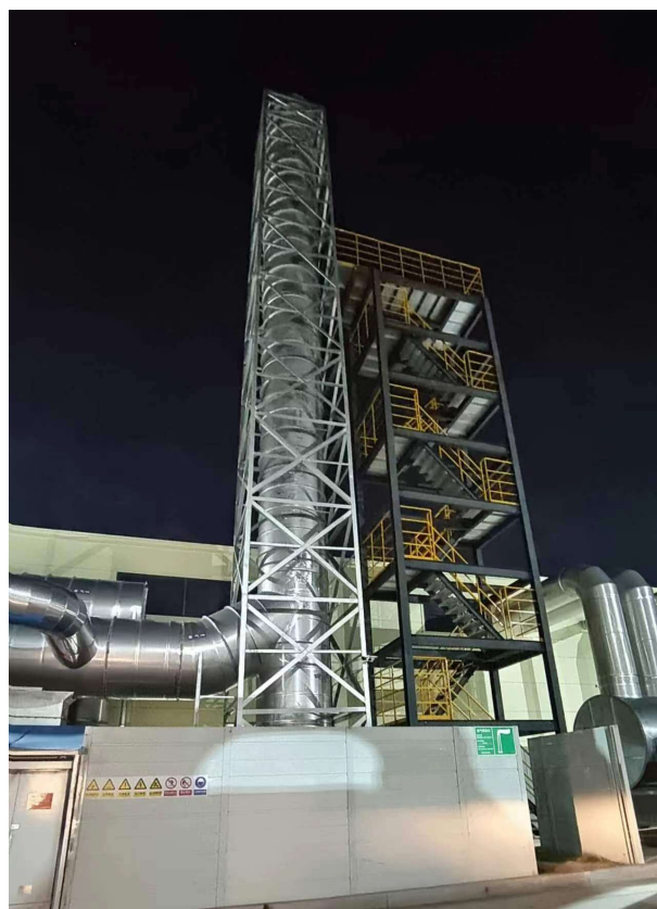
焊接废气排气筒 DA001
