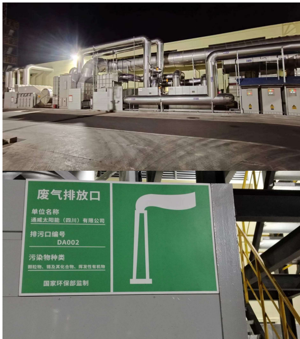
焊接废气处理设施及标识标牌 DA002
