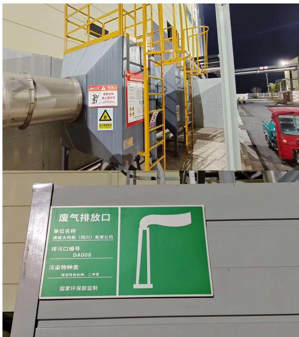
实验室废气处理设施及标识标牌 DA008
