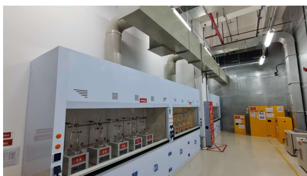
实验室废气通风橱收集
