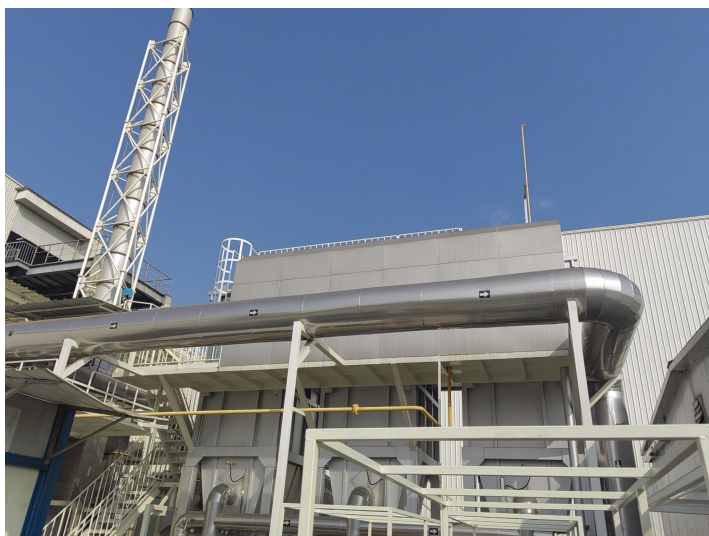
电泳废气处理系统（依托）
