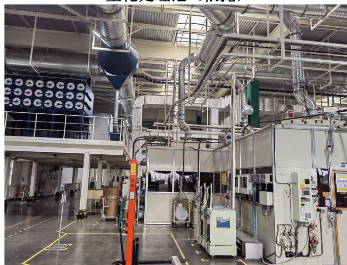
焊接废气处理系统（新建）
