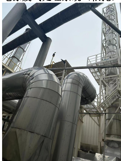
电泳烘干废气处理系统（新建）
