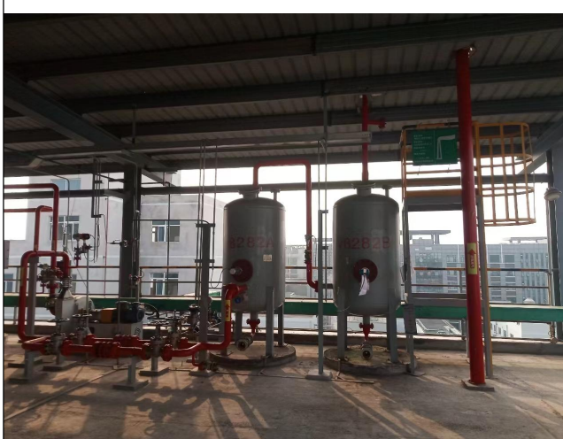
含乙炔废气处理单元处理设施及排气筒
