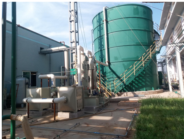
高浓废水处理设施（UASB 厌氧罐）
