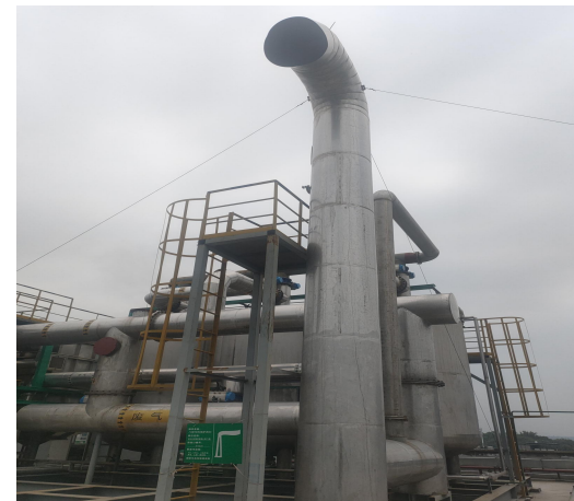
厂区集中废气排气筒
