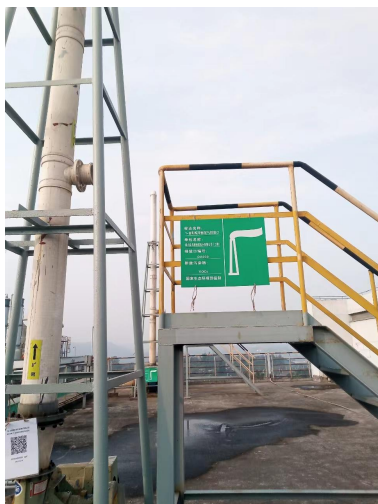
1-金刚烷甲酸废气排气筒
