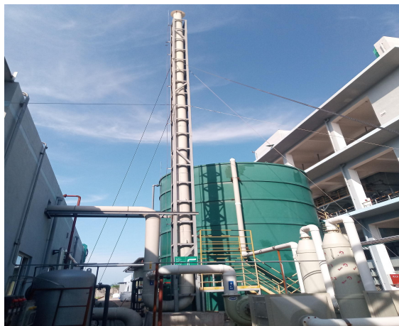
废水处理站尾气排气筒
