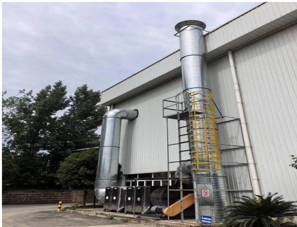
废气处理设施及排气筒
