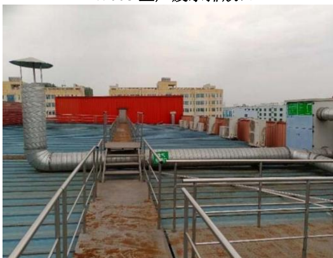
粉尘废气处理设施及排气筒
