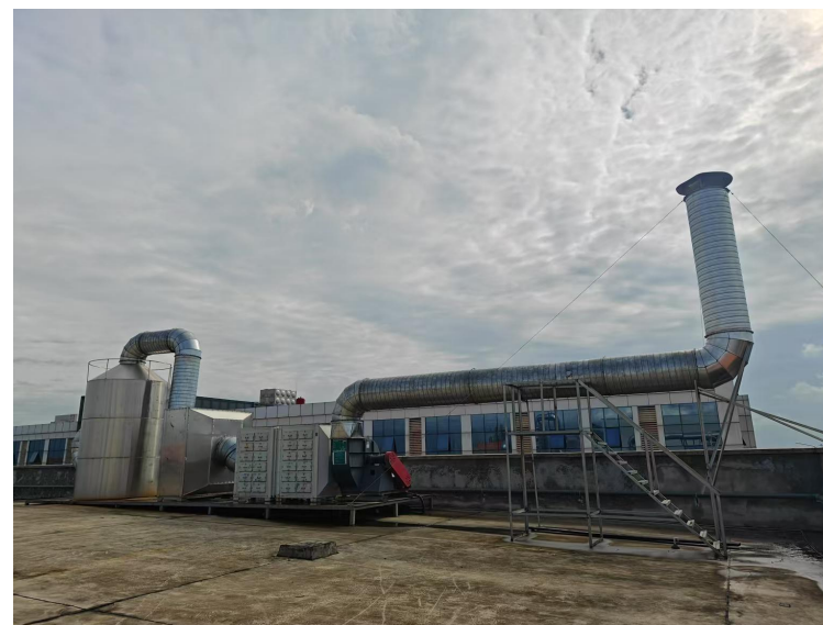
有机废气处理设施及排气筒
