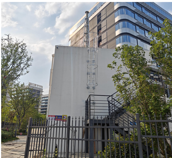
污水处理站废气排气筒
