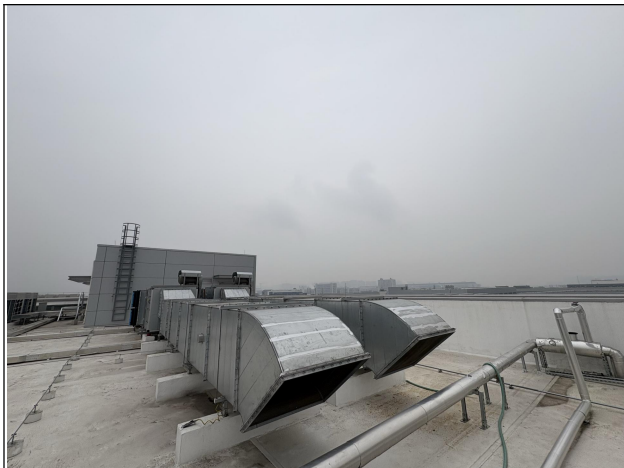
食堂油烟废气处理设施及排气筒
