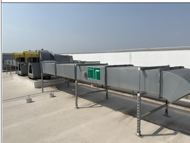
含尘有机废气 1#处理设施及排气筒
