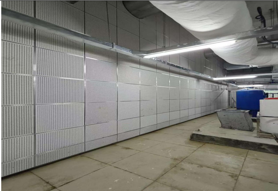
图 3-1 设备间吸音墙顶面
