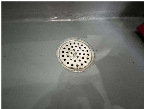
应急收集槽（通应急泄漏池）
