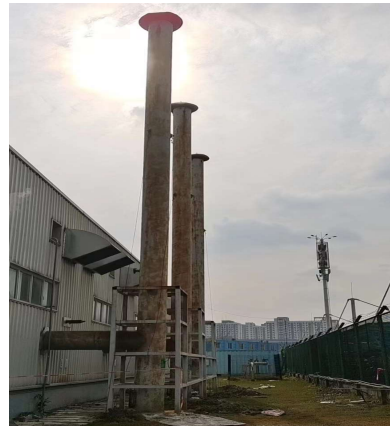
锅炉废气排气筒
