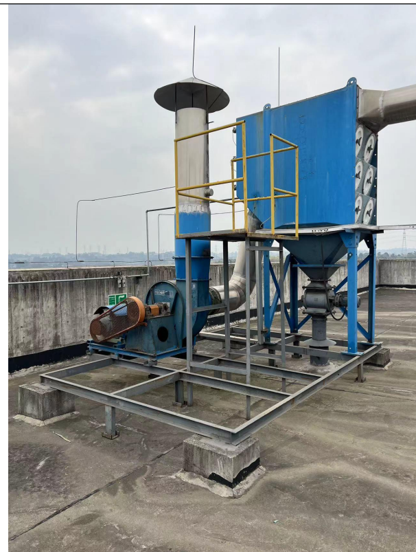
粉尘废气处理设施及排气筒
