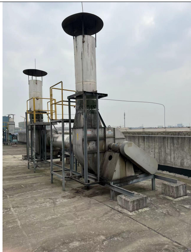
有机废气排气筒
