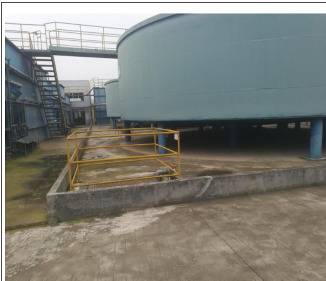
污水处理站罐体围堰
