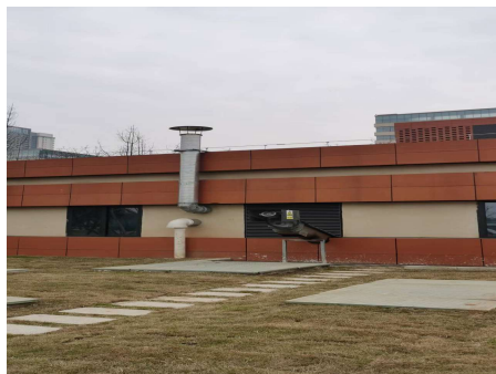
废水处理站恶臭废气排气筒
