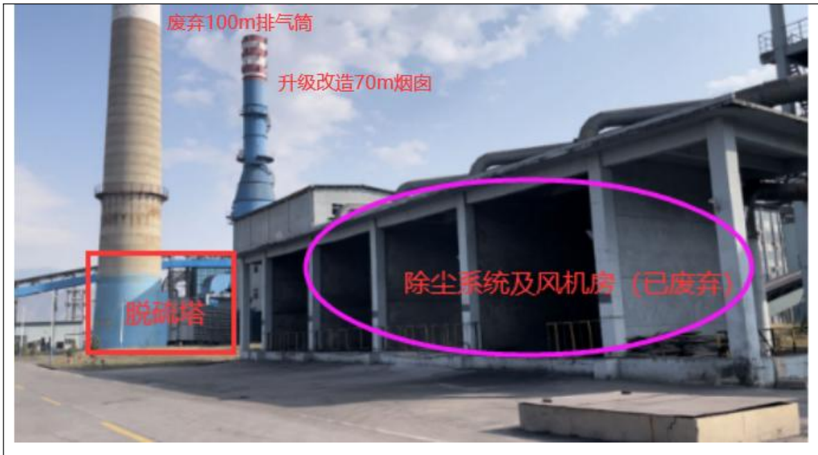
图 4-2 原富邦建设三电场除尘器+石灰石石膏法脱硫系统+100m 高排气筒
