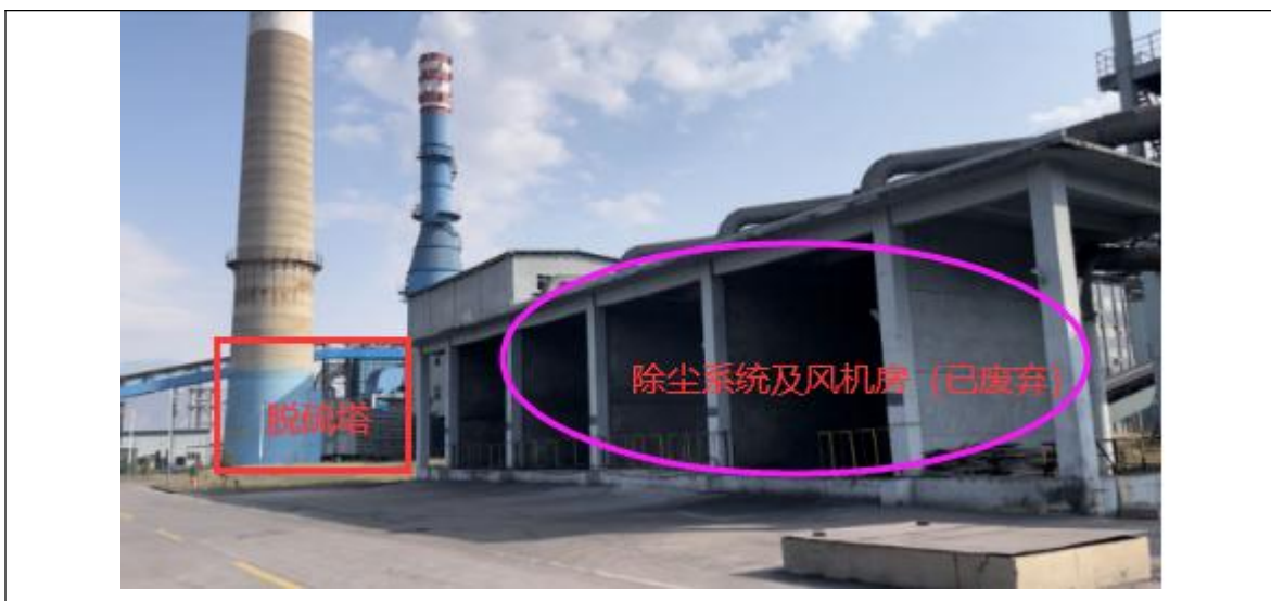
图 4-1 原富邦建设三电场除尘器+石灰石石膏法脱硫系统+100m 高排气筒
